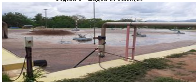
Figura 8 - Lagoa de Aeração
