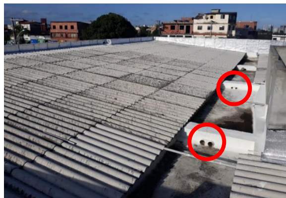
Figura 6: Telhado da Escola Novo Horizonte
