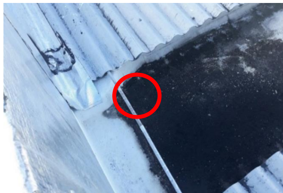
Figura 7: Telhado da Escola Novo Horizonte
