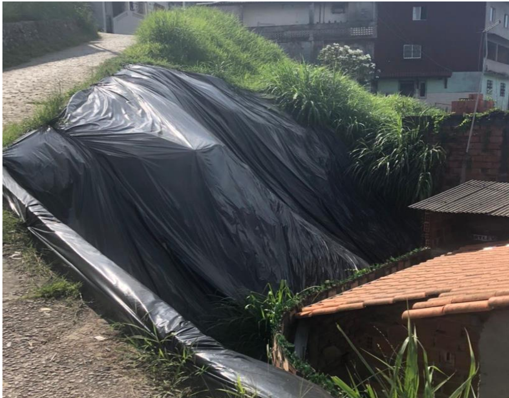
Figura 20. Talude coberto por plástico da Rua 2.
