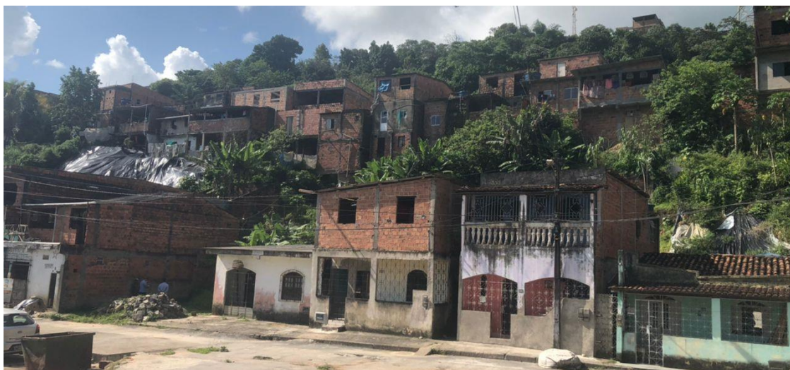
Figura 17. Vista completa da contenção da Rua 1.
