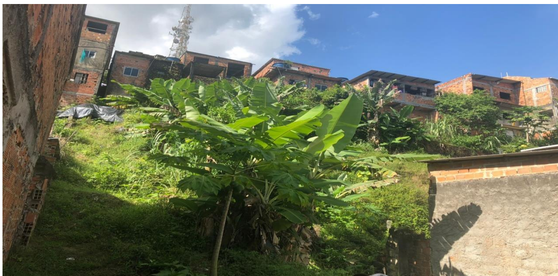
Figura 16. Acesso para contenção da Rua 1.
