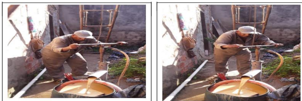
Figura 11. Profissionais realizando a sondagem Rua 2.
